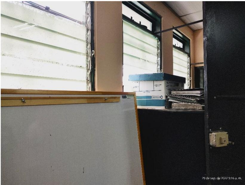
*Ilustración 9. Ventanas sin aislamiento térmico*
