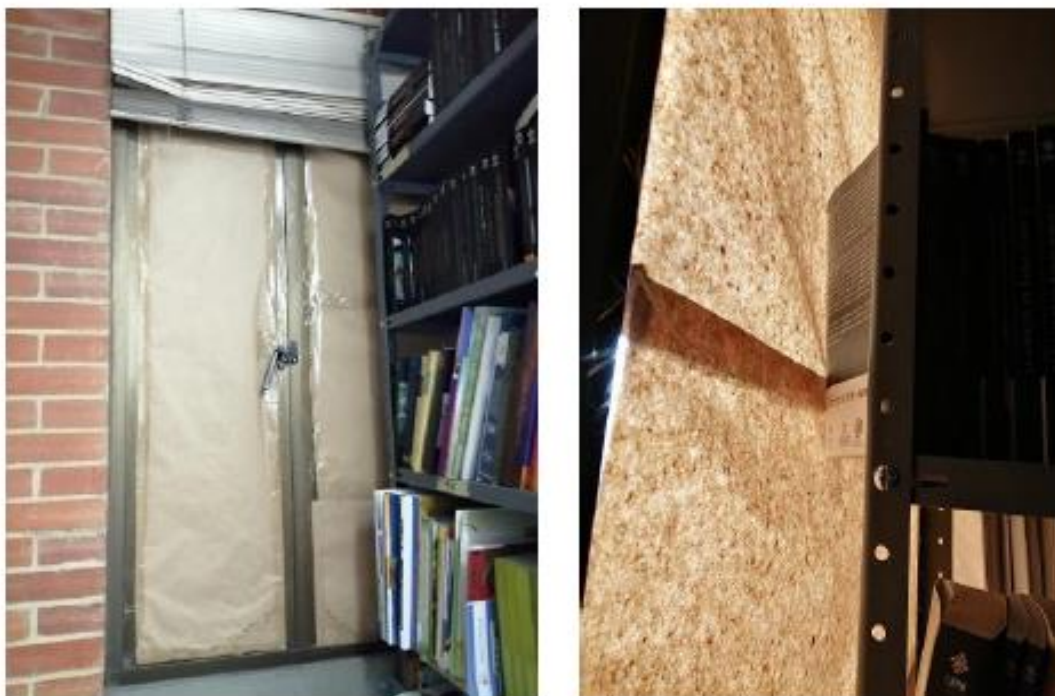
Foto No. 2 Ventanal Lugar de Almacenamiento piso 2 Sede Montevideo.
