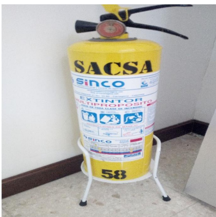
Fotografía 11. Extintor Multipropósito
