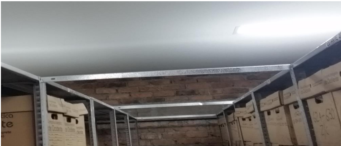
Fotografía 11 - Aseguramiento de la estantería.
