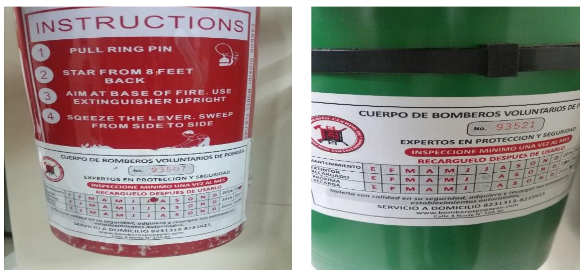
Fotografía 19 - Etiquetas de información de recarga de extintores.
