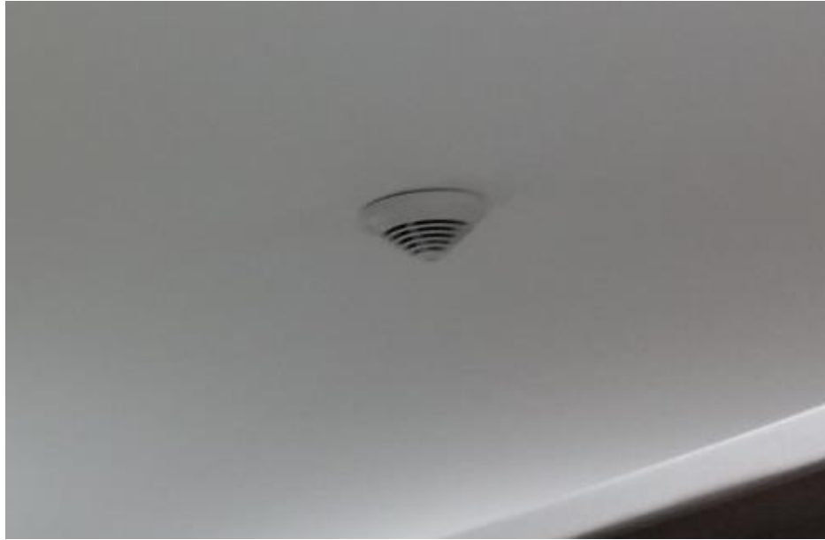
Fotografía 20 - Detectores de humo instalados en los depósitos.
