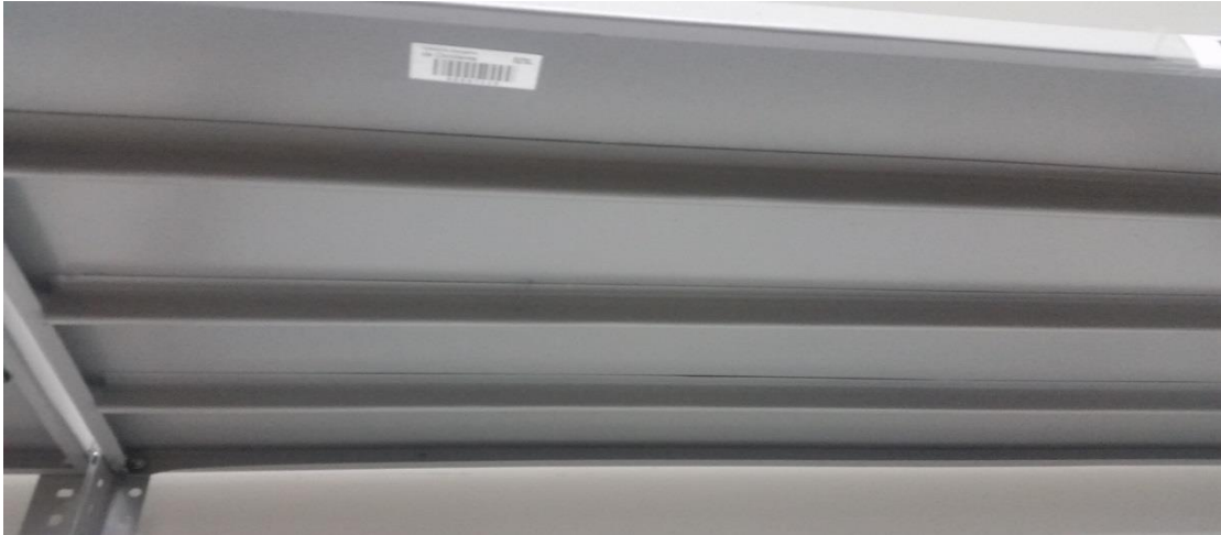
Fotografía 10 - Parales de refuerzo en las bandejas de la estantería que permiten soportar el peso de las unidades de conservación.
