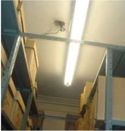
Bombilla fluorescente tubular recta que irradia luz blanca, con un sistema que retarda un poco su activación. Su consumo de energía es bajo para evitar el deterioro de la documentación. (Figura 13).
